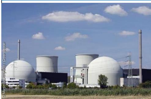
Heißer Dampf aus dem Atomreaktor treibt die **Turbine** und den **Generator** an. Es entsteht kein CO<sub>2</sub>, aber es entstehen sehr giftige Abfälle! (Die letzten 3 Atomkraftwerke in Deutschland wurden im April 2023 abgeschaltet.)
