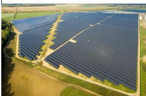
Auf einem Feld in Brandenburg erzeugen **Photovoltaikmodule** elektrischen Strom **ohne** Generator und **ohne** CO<sub>2</sub>. Das Solarfeld hat **465.000 Photovoltaikmodule**
